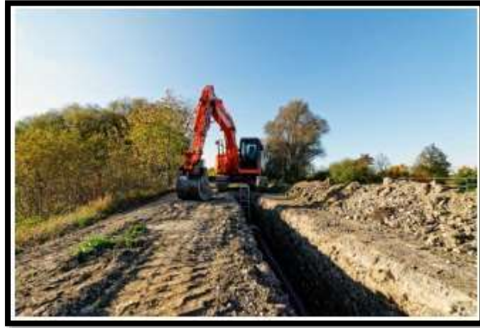
Figure VII-3 : Tranchée par pelle rétro
