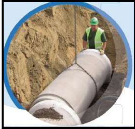
Figure VII-4 : mise en place des canalisations
