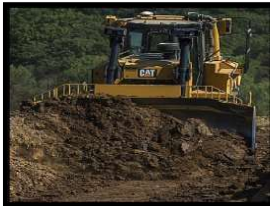
Figure VII-2 : décapage par bulldozer
