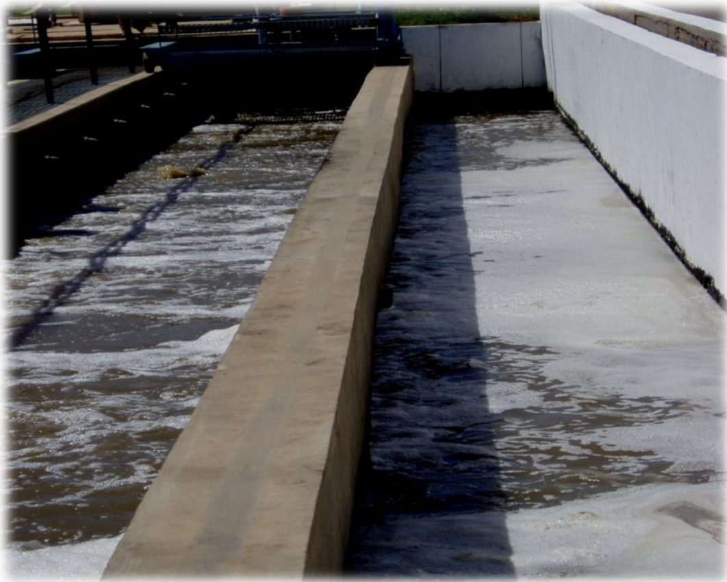
Figure III-02- : Poste dessablage-déshuilage
