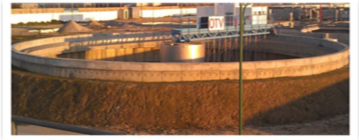
Figure III-04- : Poste de décanteur primaire
