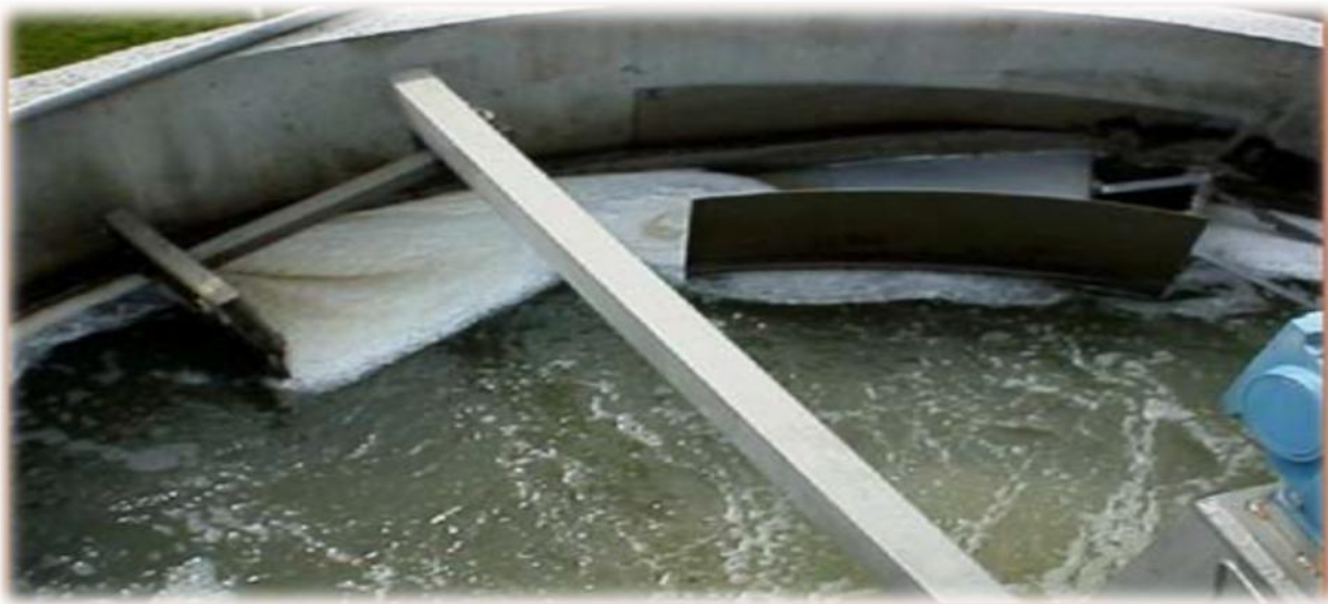
Figure III-03- : Racleur des graisses
