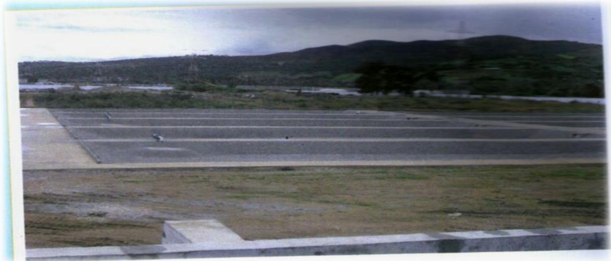
Figure III-07- : Poste de déshydratation naturelle (lit de séchage).
