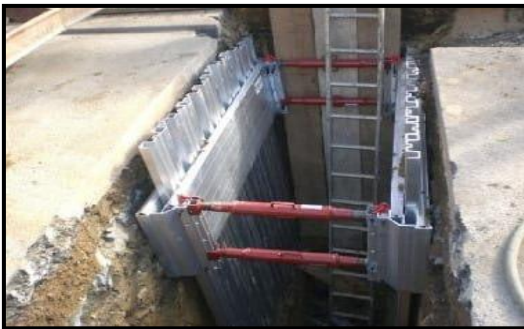
Figure VII.1: Soutènement par blindage
