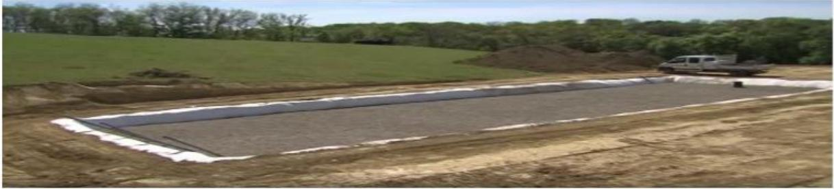
**Fig VII.5 :** remplissage des bassins avec le gravier et sable(page officielle youtube)
