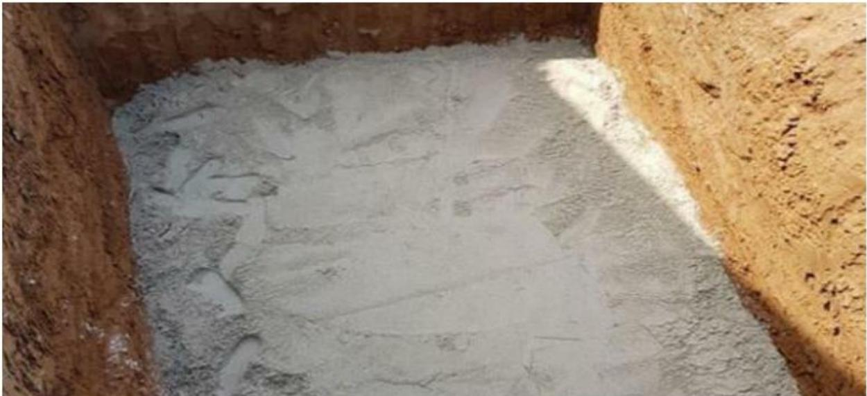
**Fig VII.2 :** lit de pose d'une micro station d'épuration
