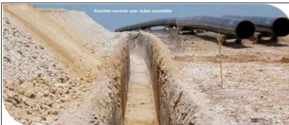
Figure VII. 4: tranchée ouverte avec tubes assemblés.
