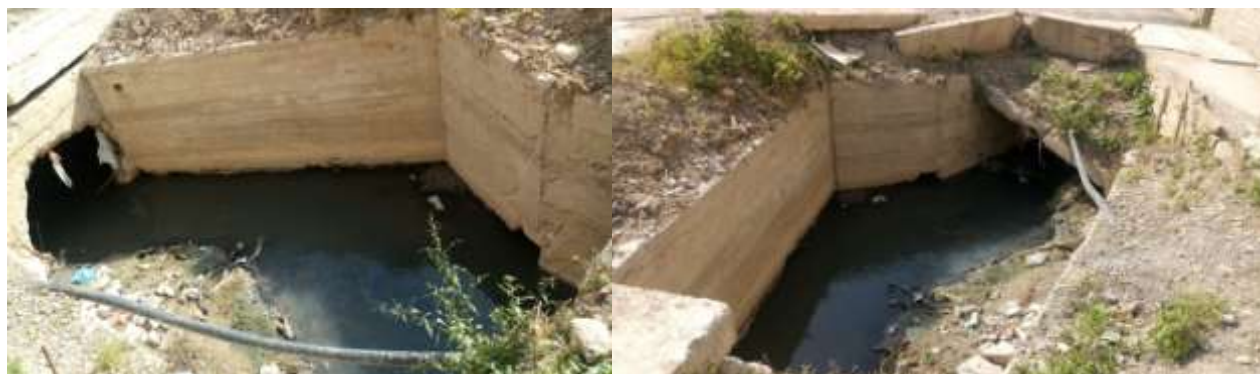
Figure II. 6: Ouvrage de régulation, Boulevard Krim Belkacem Aamriw (prises par l'étudiante 20/04/2019)
