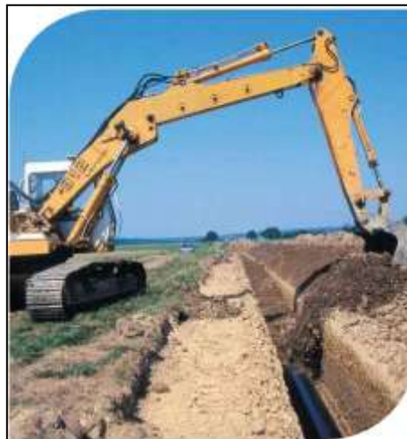
Figure VII. 7: Remblaiement de la tranchée.
