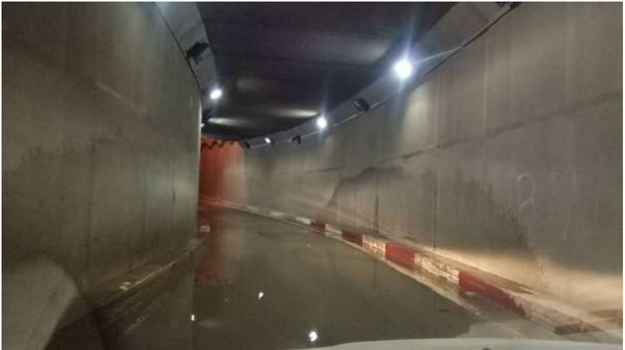
Figure II. 10: Trémie d'Aamriw inondée (Aout 2018).
