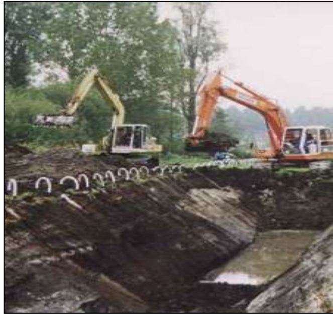
Figure VII. 2: pompage des eaux dans les tranchées.
