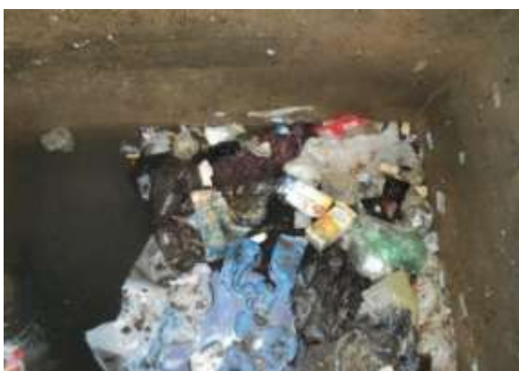
Figure II. 4: les problèmes concernant les regards du réseau de la zone (prise par l'étudiante 26/08/2019)
