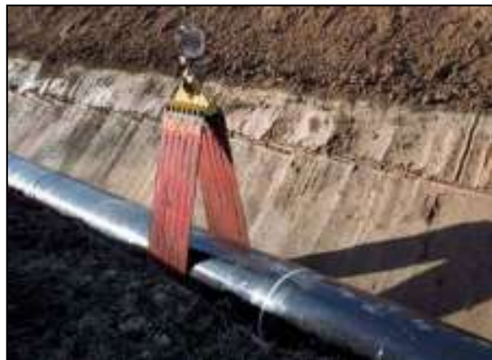
Figure VII. 5: Mise en place des conduites.
