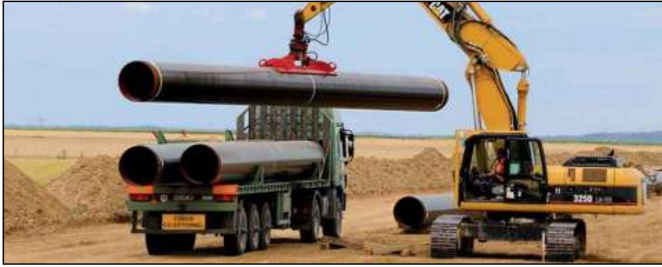
Figure VII. 3: transportation des tubes sur piste.
