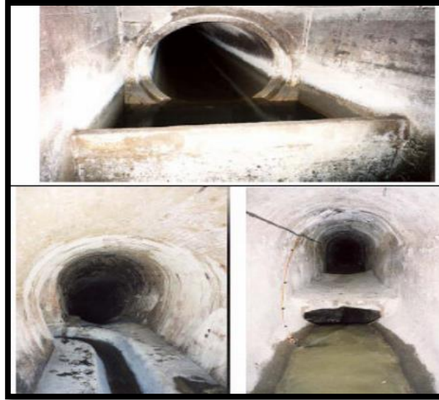
Figure VI.16 : Exemples de déversoir frontal
