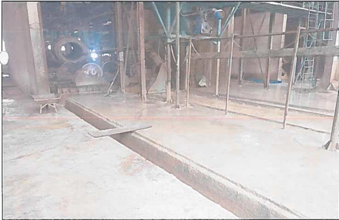
Figure N° I-3-Caniveaux de drainage.
