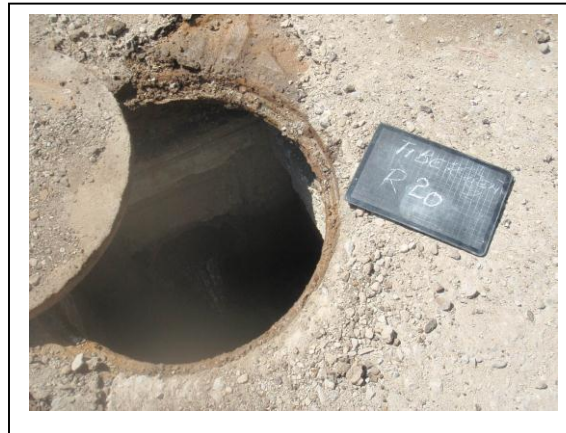
Figure II.5 regard en mauvais état
