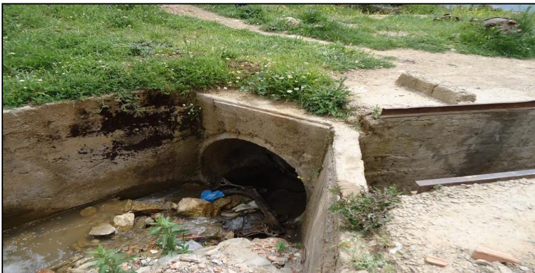
**Figure V. 21:** Conduite existantes de diamètre 2000mm (Source : DRE Bordj Bounaama)
