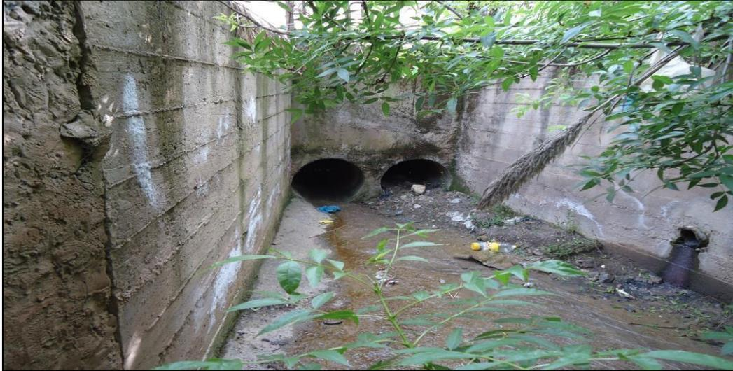
**Figure V. 32:** Réfraction à deux Conduite existantes de diamètre 1000mm (Source : DRE Bordj Bounaama)
