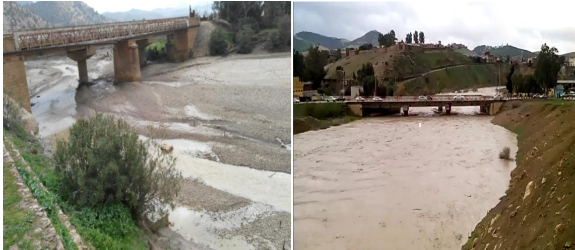
Figure IV.3 : Pont existant au niveau de la route national RN 90
