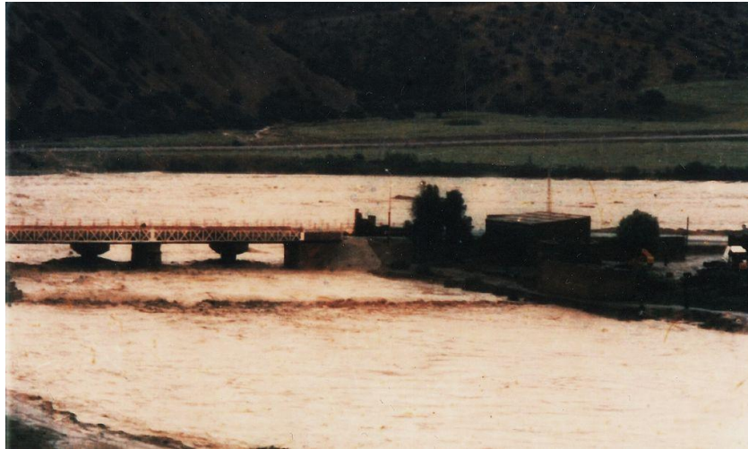
Figure IV.2 : Photos sur oued Rhiou lors d'une crue au niveau du pont de la route nationale RN 90
