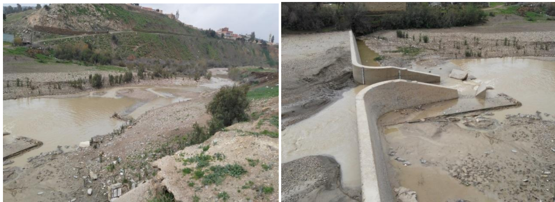
Figure IV.4 : Photos prises sur oued Rhiou par le bureau d'étude hydro-technique BEHY
