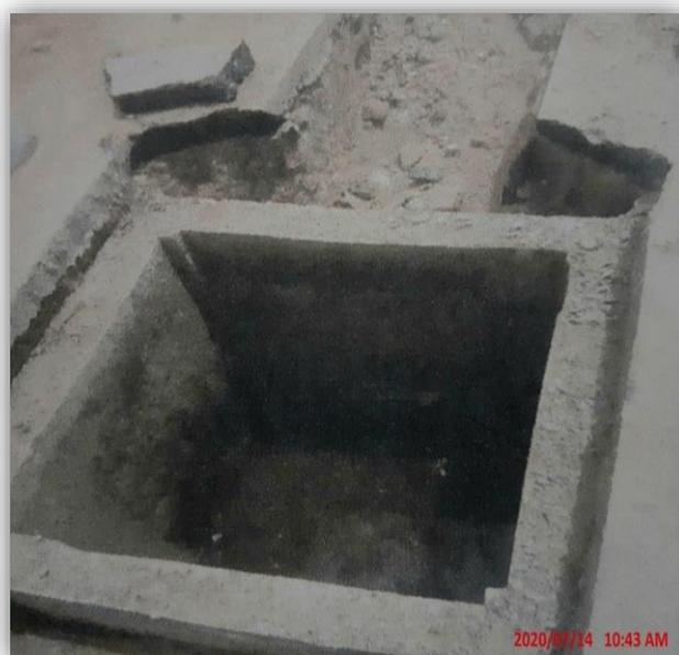
**Figure N°II.6** : regard bétonné (regard N°B205 cite socolech)
