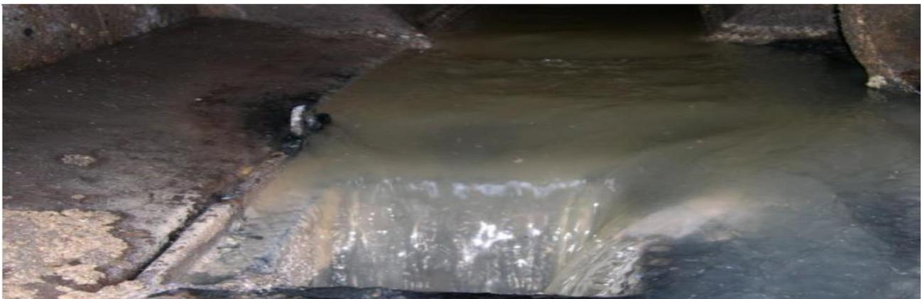
Figure N°VII.18 : déversoir à ouverture de fond.
