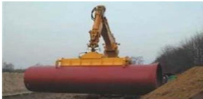
Figure N°VIII.6 : pose de canalisation en fonte.
