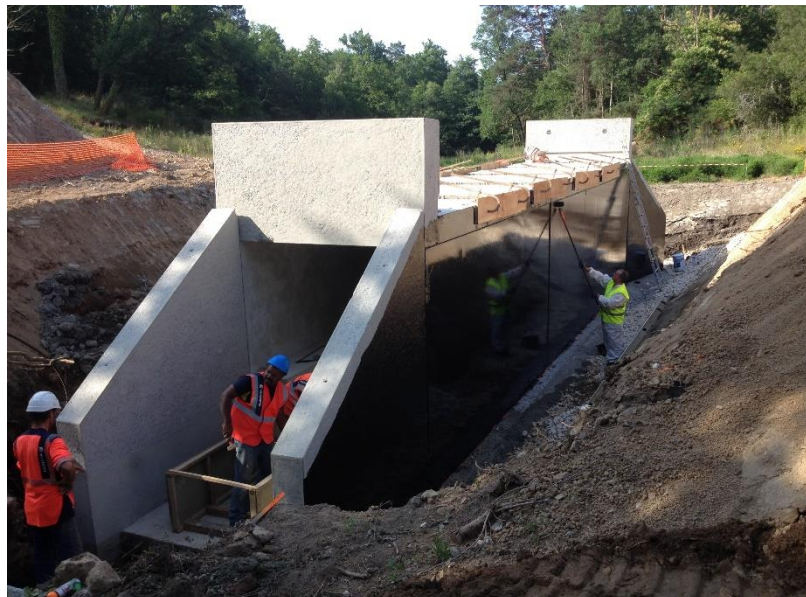
Figure V.15 : les dalots fabriqués sur terrain en béton armé
