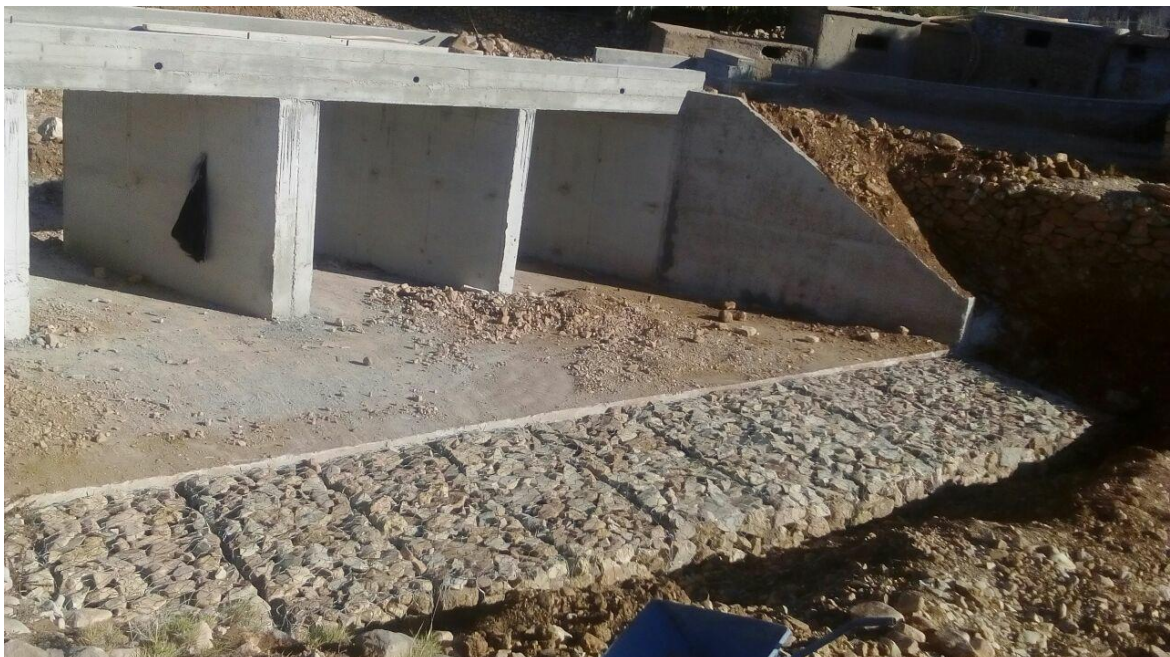
Figure V.23 : la phase finale de la réalisation d'un dalot
