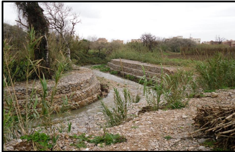
Figure IV.3 : l’état du tronçon P1 aménagé d’oued Palm Beach
