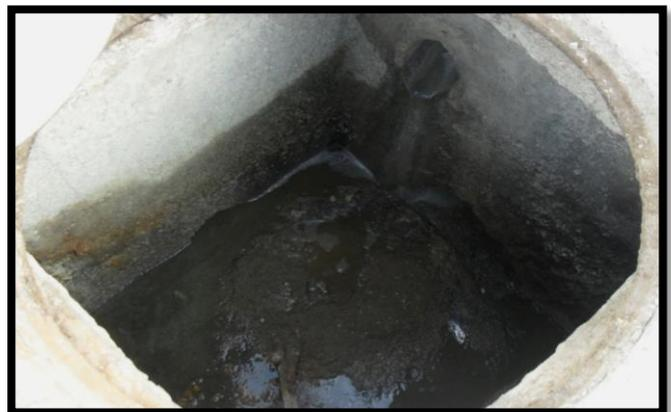
Regard N°D44 : endommagé avec risque de contamination et Présence énorme de dépôt qui gêne l'écoulement des eaux. (Date : 18/03/2020)
