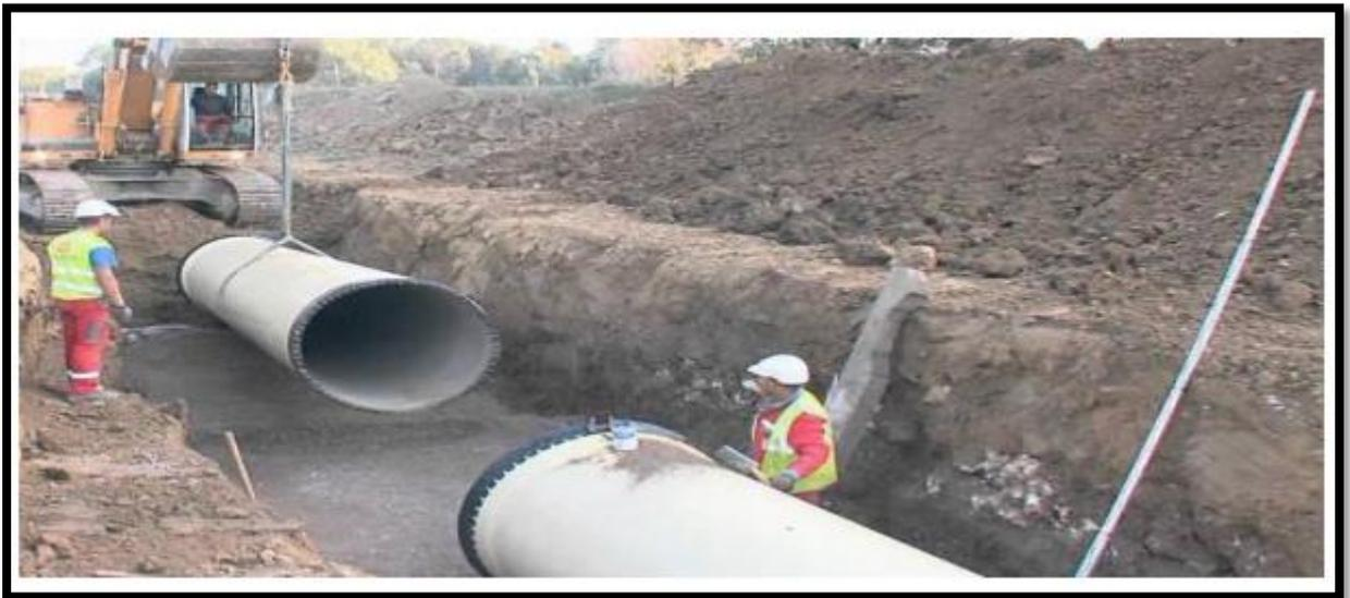
**Figure (VIII-3) : Assemblage des tuyaux en béton.**
