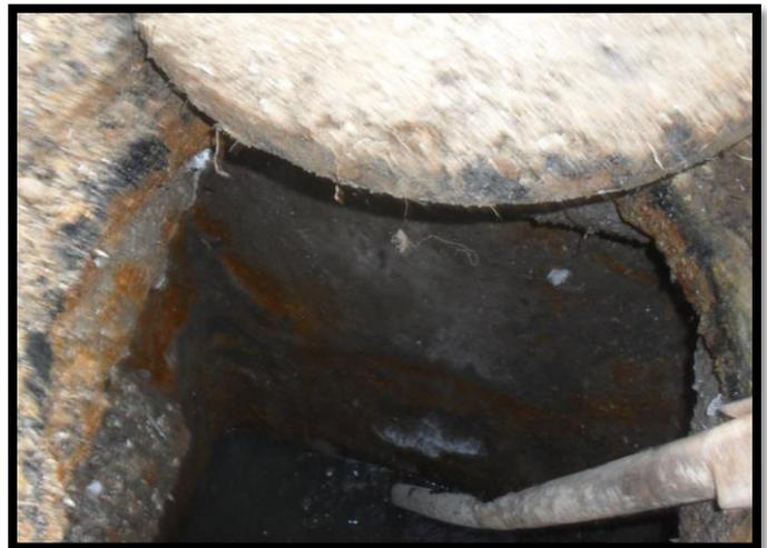
Regard N°A52 : endommagé avec risque de contamination et Présence énorme de dépôt (Date : 18/03/2020)
