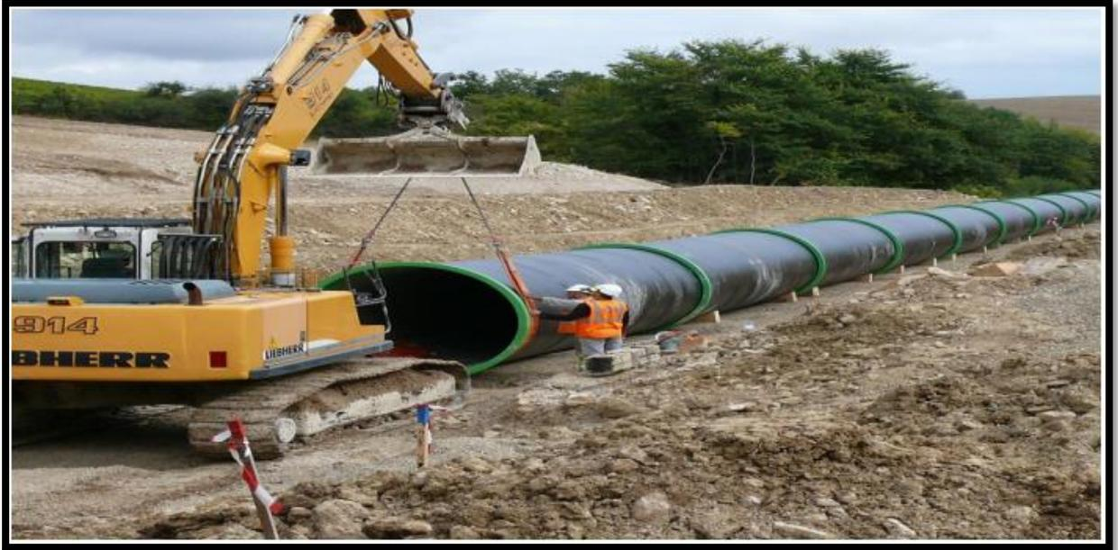
**Figure (VIII-2) : Pose de la canalisation.**
