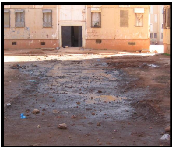
Figure II-3. Débordement des eaux usées
