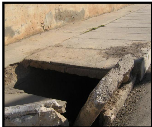
b. Rejet eaux pluviales canal (oued aménagé)
