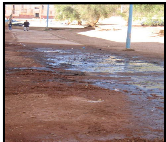
Figure II-3. Débordement des eaux usées
