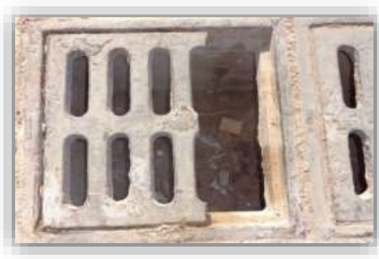
Figure II-3 : grilles abimées (Juillet 2019)
