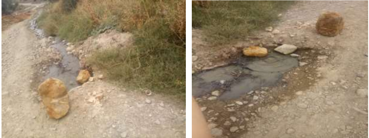
Figure II-1 : regards débordés (Juillet 2019)
