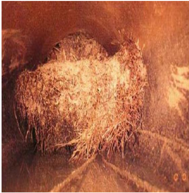
Figure II.3: Exemple de blocage Par la présence de racines.
