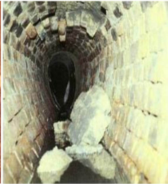
Figure II.4 : Exemple d'obstruction
