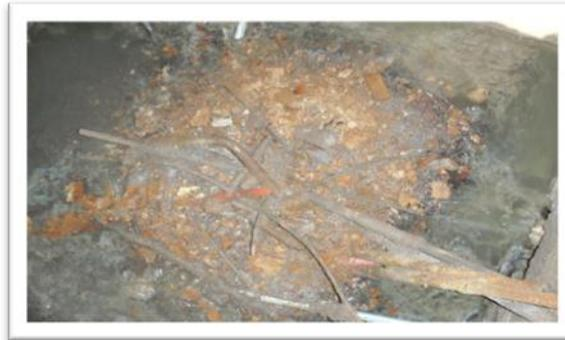
**Figure II-3 :** Regard n°14 contient peu de terre, de déchet et sans tampon (diamètre d'entrée et de sortie est de 500 mm, profondeur de 1.5 m).
