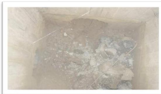
**Figure II-2** : Regard n° 16 plein de déchets et sans échelle (diamètre entré de 300 mm et de diamètre de sortie de 400 mm, de profondeur de 2.5 m).
