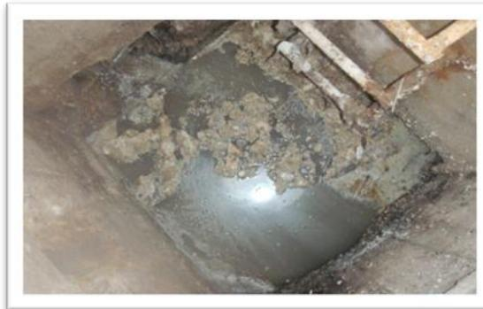
**Figure II-4 :** Regard n° 05 contient un peu de terre avec une échelle (diamètre d'entrée et de sortie est 500 mm, de profondeur de 2.1 m).
