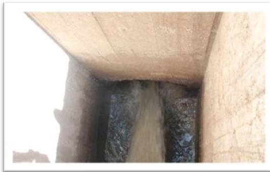
**Figure II-1** : Regard n° 87 contient un peu de terre, sans échelle et sans tampon (diamètre d'entrée et de sortie est 600 mm et de profondeur de 2.7 m). (Source DRE Mila 2016).
