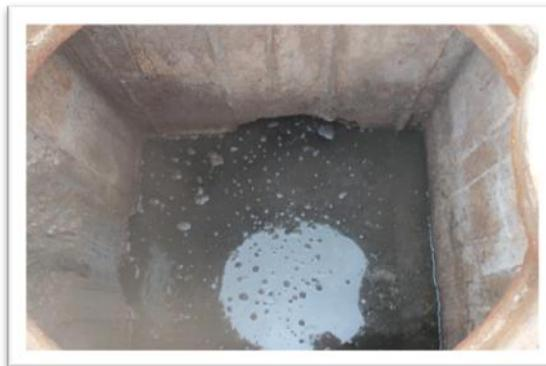
**Figure II-5 :** Regard n°25 contient un peu de terre et envasement 0.2 m, (diamètre d'entrée de 500 mm et de diamètre de sortie de 500 mm, de profondeur de 2.00 m).
