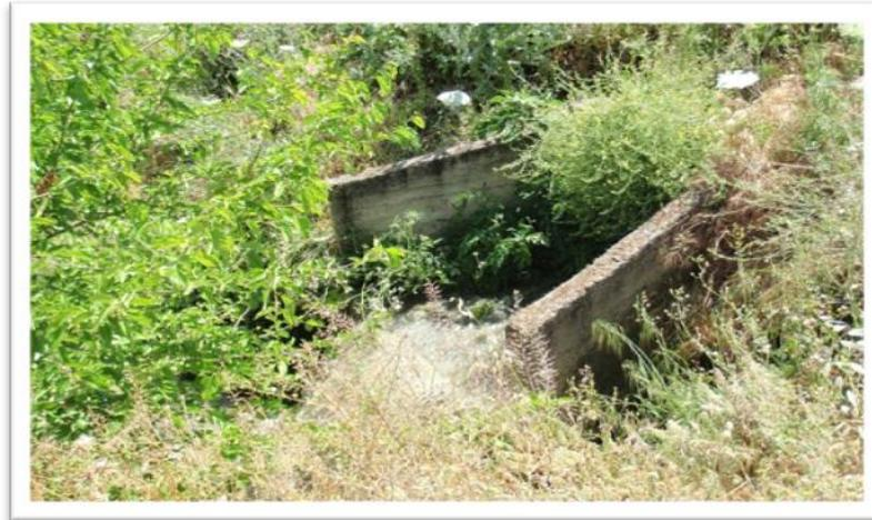
**Figure II-7 :** Ouvrage de rejet (à ciel ouvert), en mauvais état (source DREW Mila 2016).
