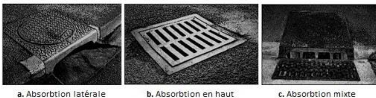
Figure VI.6: Bouches d'égout. Source (Google)
