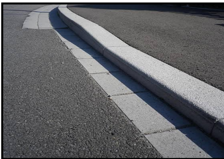
Figure VI.5 : Exemple D'un type des caniveaux. Source (Google)
