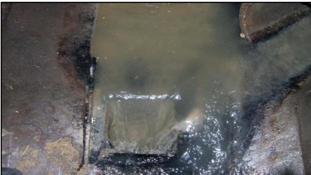
Figure (VI-16) : Déversoir à ouverture de radier
