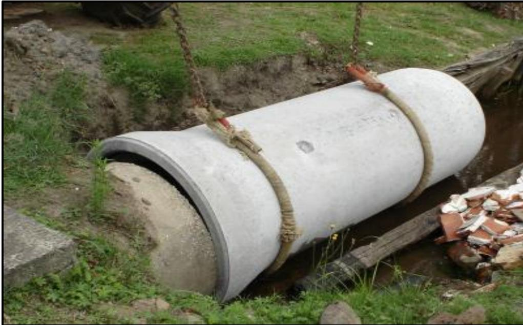
**Figure (VII-7): assemblage des tuyaux en béton**
