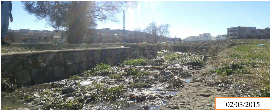
Figure 5.1 : photo représente les dépôts dans un ancien canal
