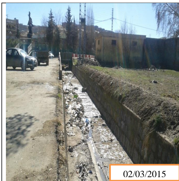
Figure 1.6 : canal mal réalisé
