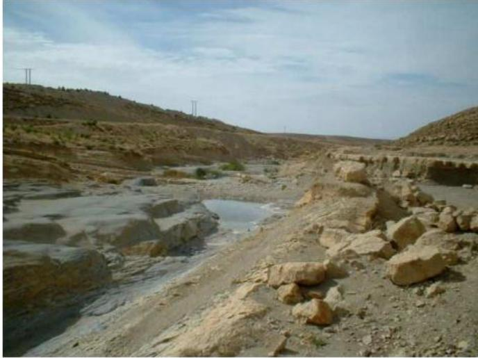
**Figure II.7** : Erosions dans le chenal aval de l'évacuateur.
