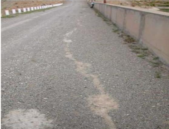
**Figure II. 5** : Indication des fissures en crête de digue.
