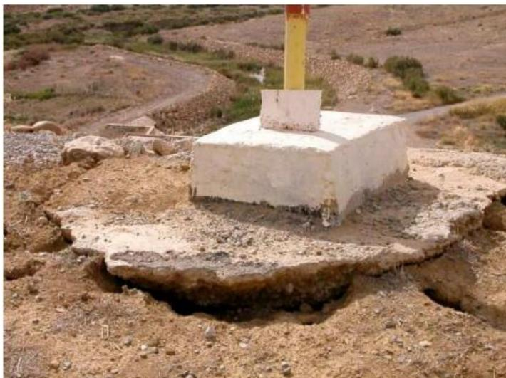
**Figure II.4 :** Indications de mouvement et de tassement en crête en amont du barrage
