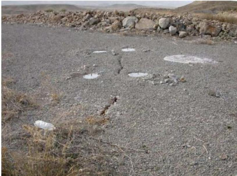
**Figure II.6** : Fissure rive droite traversant la chaussée.
