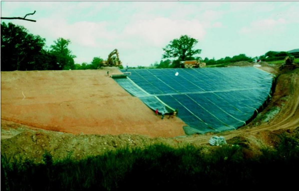
**Figure IV.3. Exemple de mise en place d'une géomembrane bitumineuse [9]**
