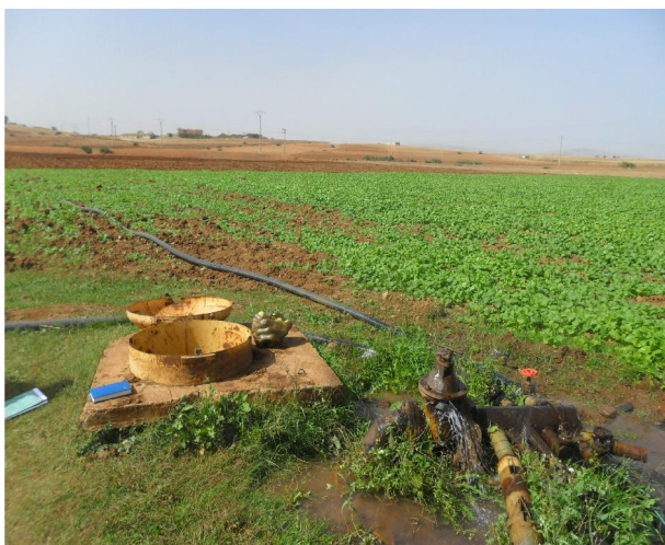
Figure 6 : Etat des bornes-type B- (ø150)
