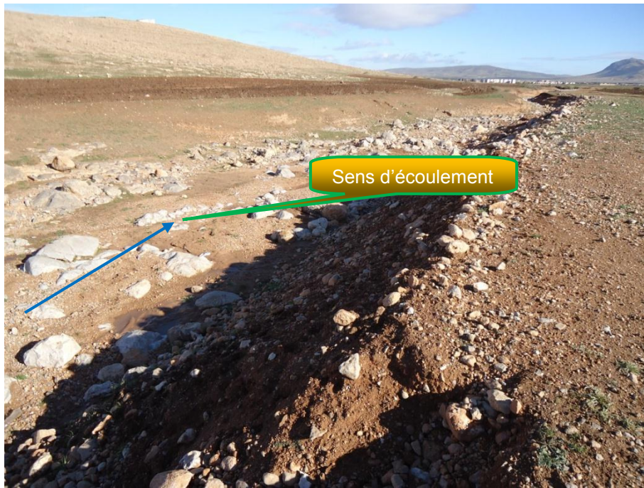
Fig. IV. 1 : Section de l'oued juste à l'aval de la retenue (Affleurement calcaire du lit d'oued)
