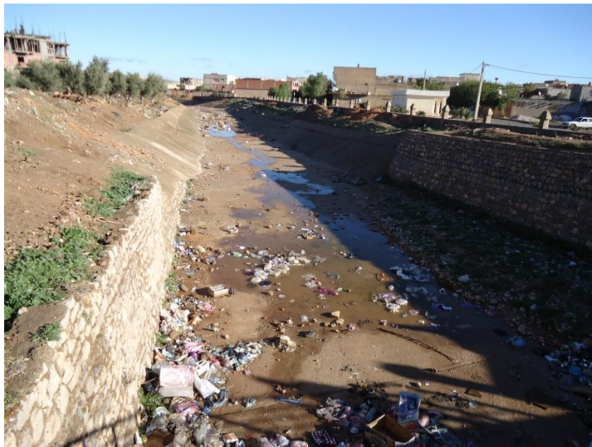
Fig. IV. 5: Vue à l'aval du pont existant
