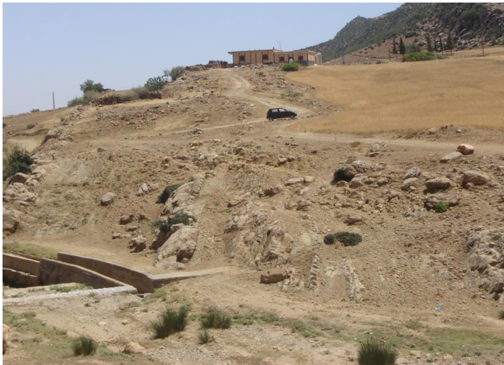
Figure II.3 Rive droite du site et affleurements porteurs d'appui de la digue
