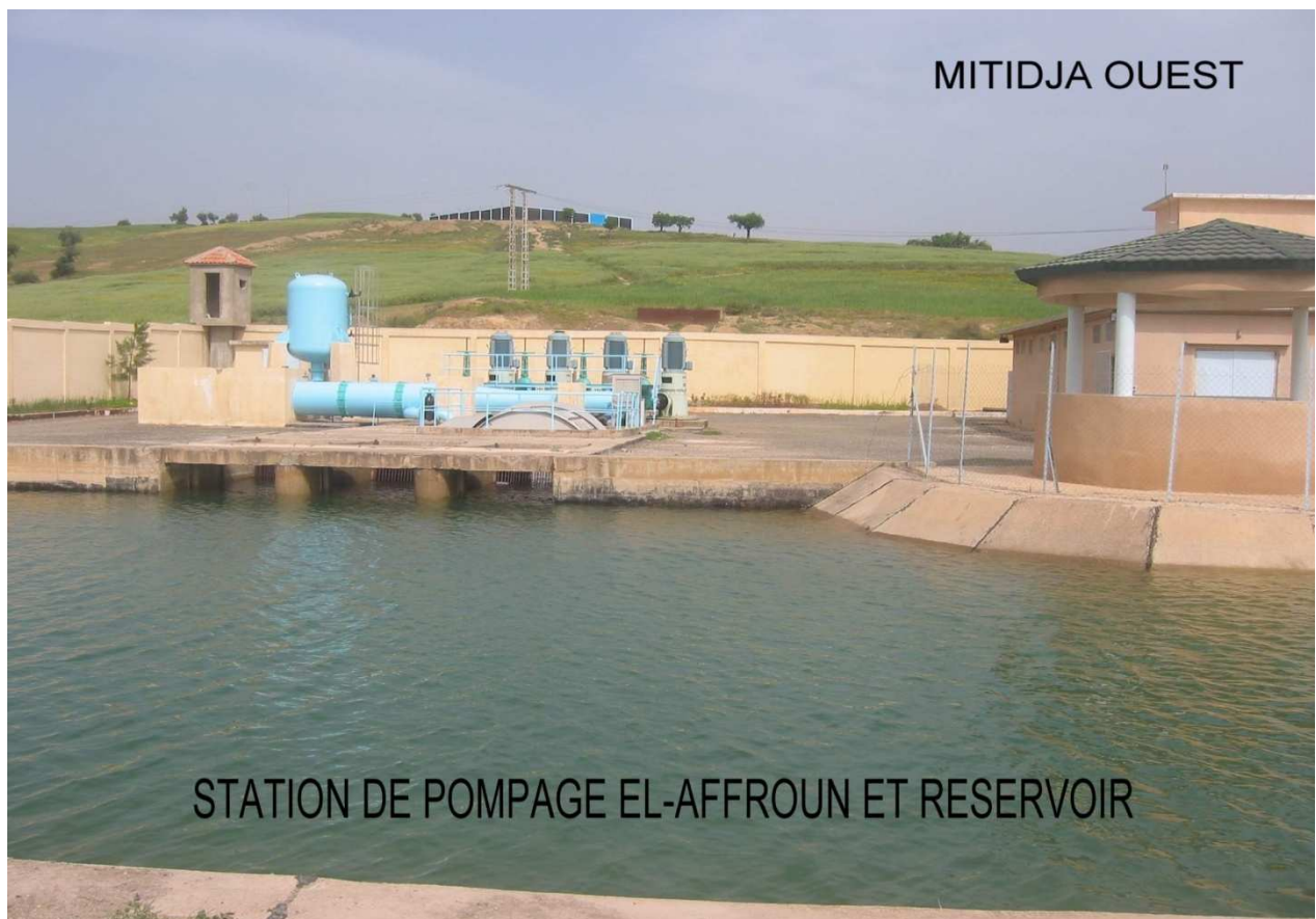
Figure II-6 : Vue de loin du réservoir El-Affroun.
