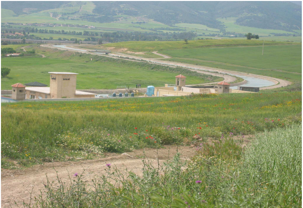
Figure II-3 : Vue générale de canal rive gauche et la station de pompage El-Affroun.
