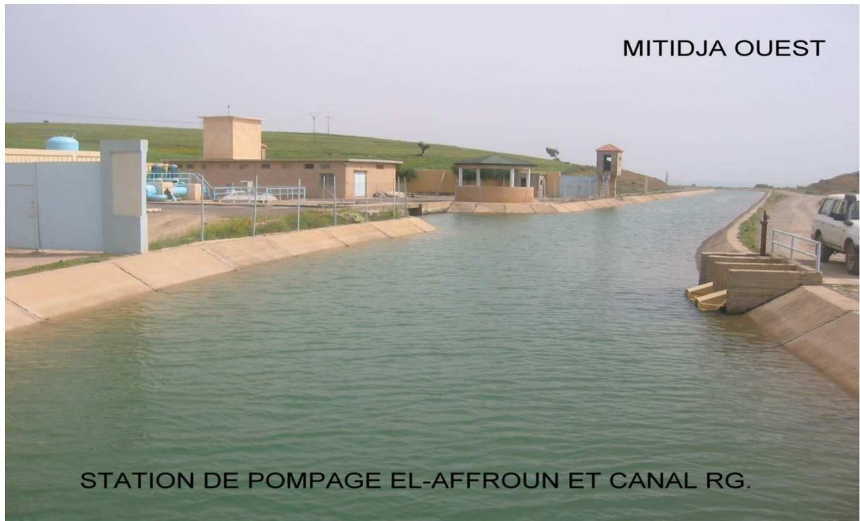
Figure II-4 :Vue proche de la station de pompage.
