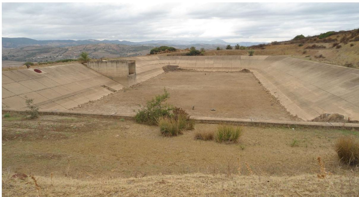
Figure N° V. 10 : Réservoir de régulation journalière envasé (ONID 26/02/2014)
