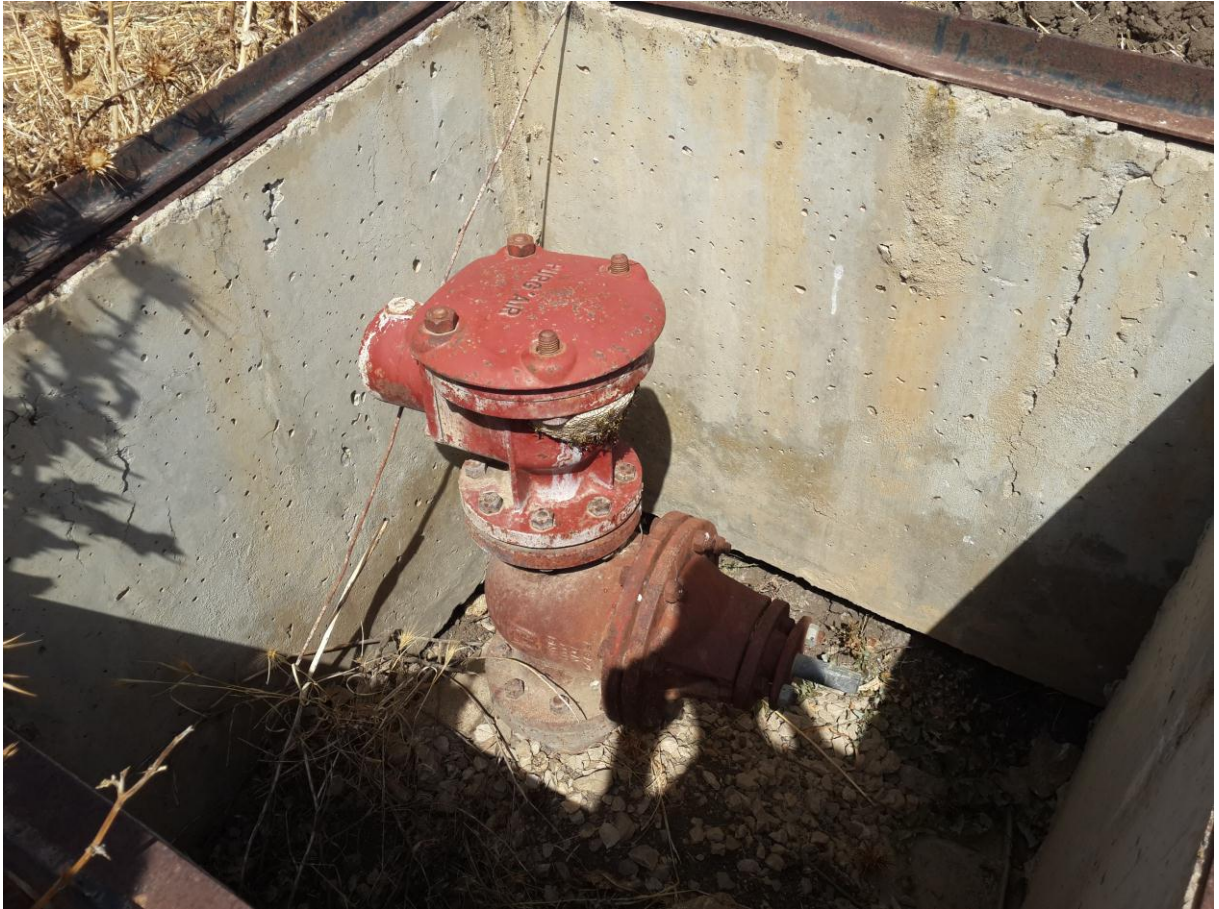
Figure N° V. 11 : Ventouse à l'état actuel (24/08/2015)
