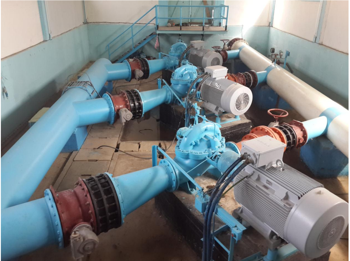
Figure N° V. 4 : Station de pompage d'El-Harrouch (24/08/2015)
