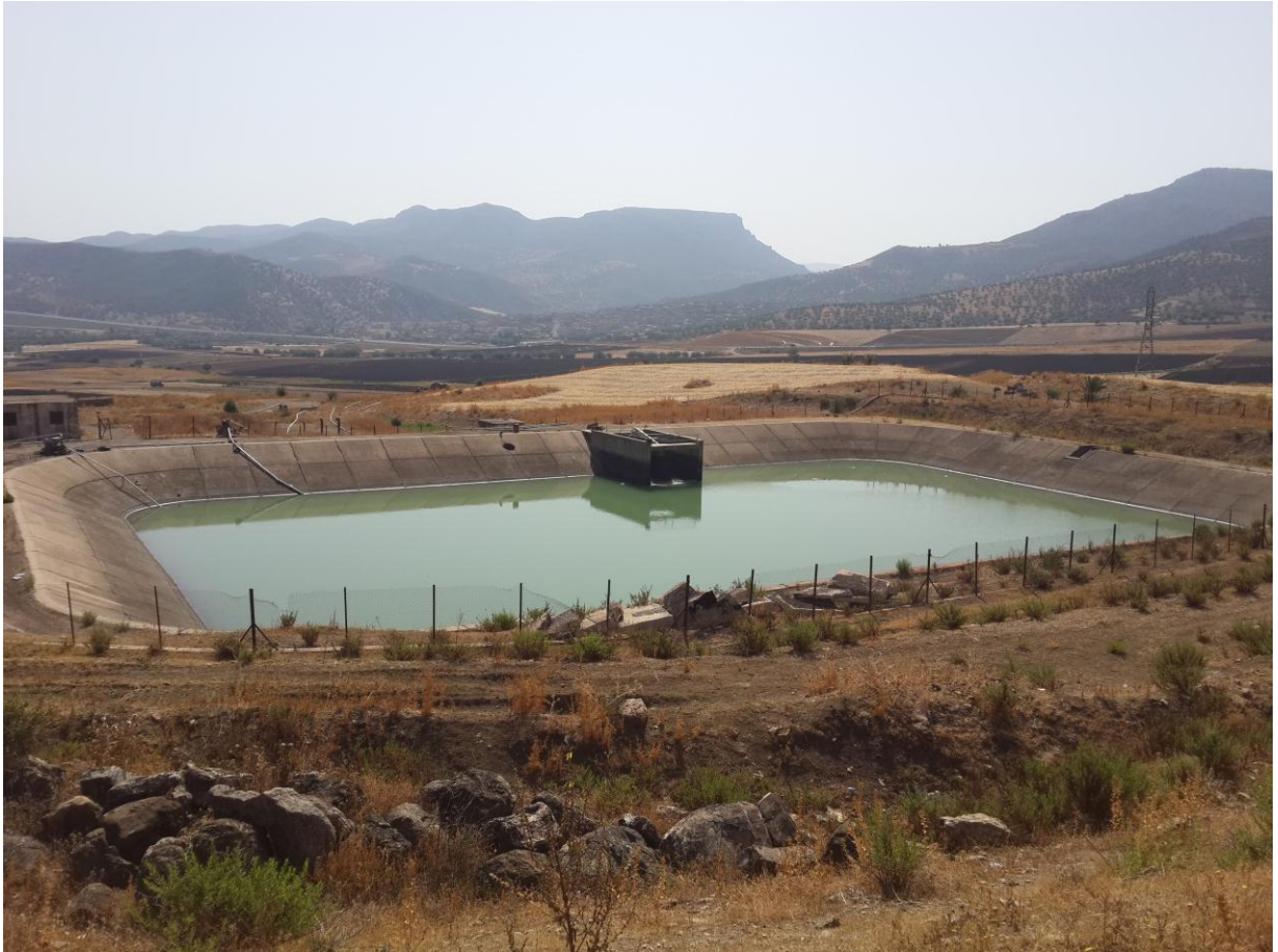
Figure N° V. 2 : Réservoir de régulation journalière « R N°3 » (24/08/2015)
