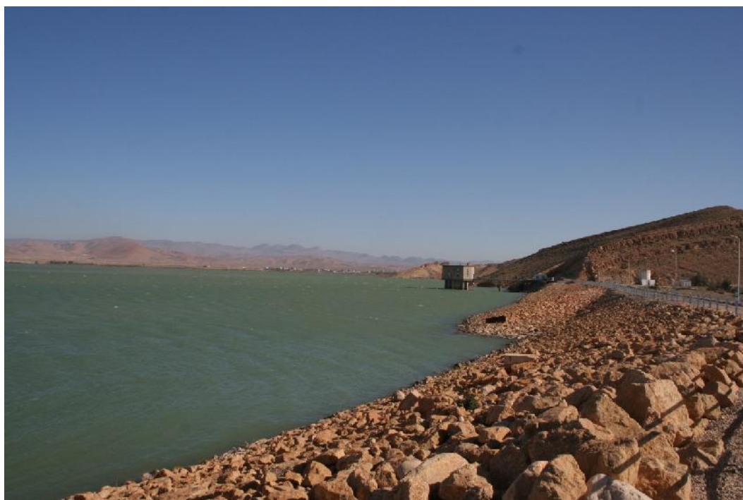
Figure III-1 : Vue générale de la cuvette du barrage de fontaine des Gazelles
