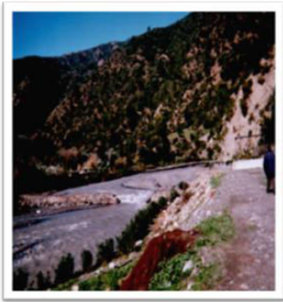
Figure I.3: Vue de l'axe N°1 du barrage Magtaa Lazreg
