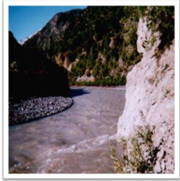
Figure I.4 : Vue de l'axe N°2 du barrage Magtaa Lazreg
