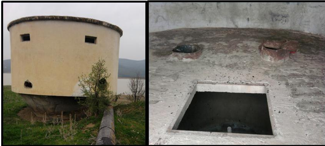
Figure IV -2 : ouvrage de prise d'eau
