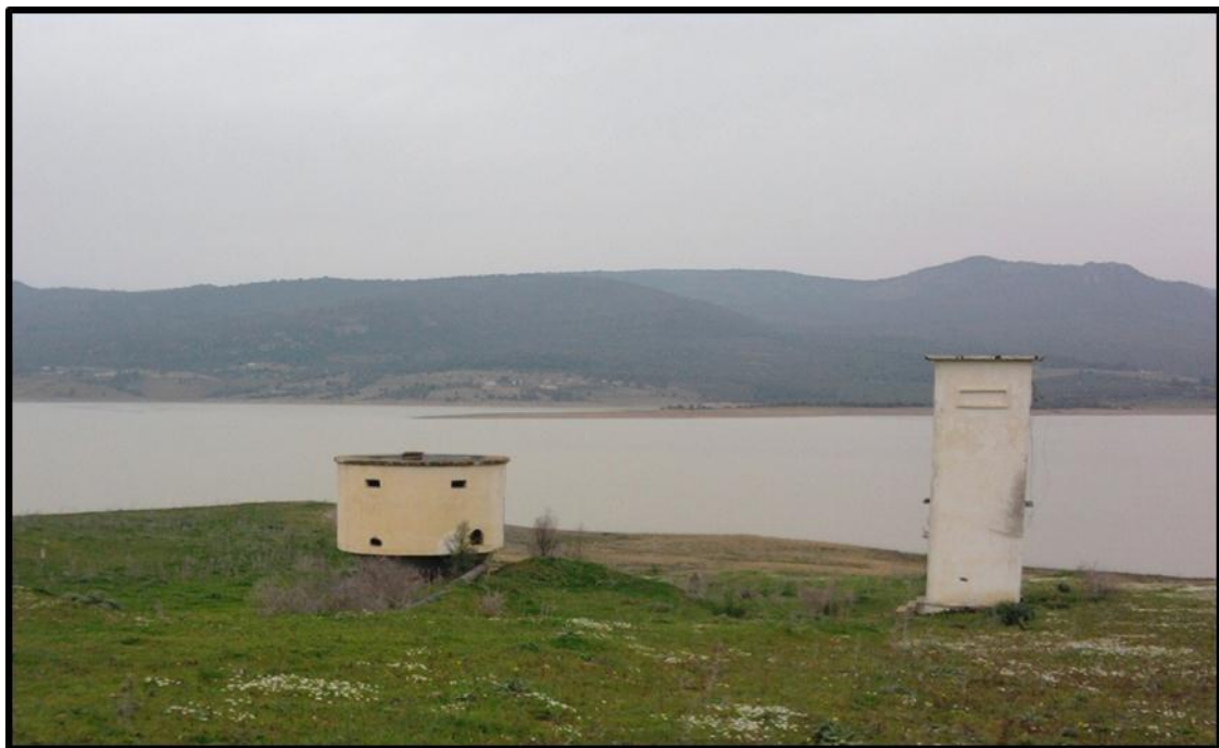
Figure IV -1 : Barrage de CHEFFIA
