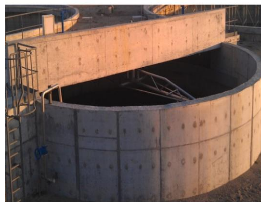
Figure IV.8: Poste de dégazeur.
