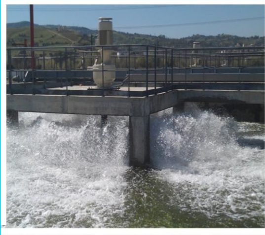
Figure IV.7 : Poste de Bassin d'aération
