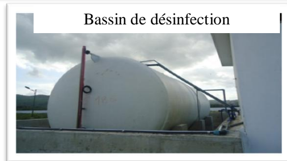
Figure IV.10 : Poste de désinfection des eaux traitées.
