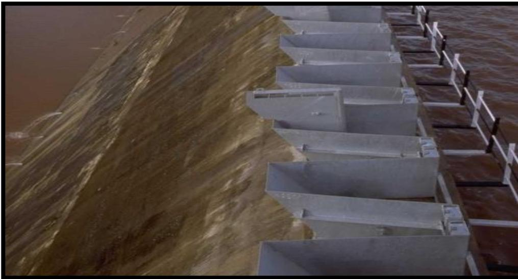
**Figure III.18 :** Deux hausses qui se partagent le même puits Barrage de Kakdiamba (8)
