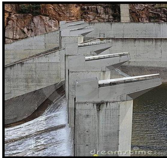
**Figure III.7:** Hausses à crête rectiligne (3)
