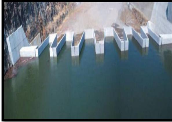
**Figure III.17:** Puits d'alimentation regroupés dans des chambres aménagées dans les bajoyers.
