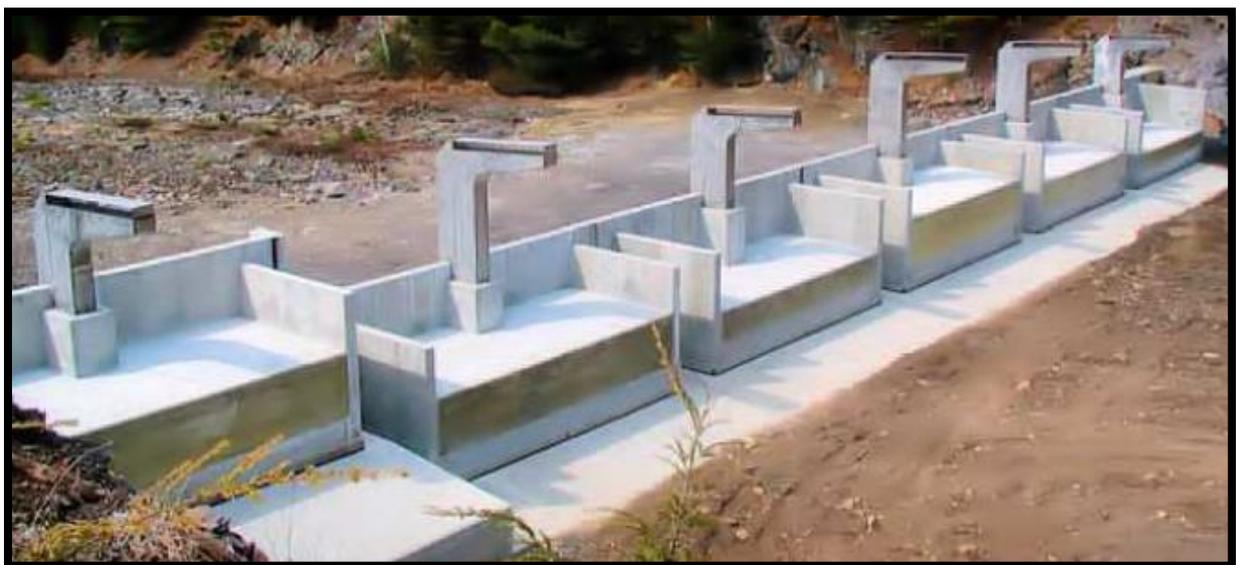
**Figure III.12:** Hausses posées sur un seuil en marche d'escalier (5)
