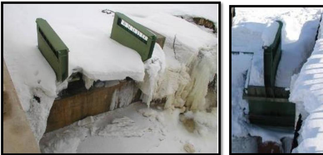
**Figure III.30** : Hausses fusibles sur le barrage de Khorobrovksaya (LACROIX)
