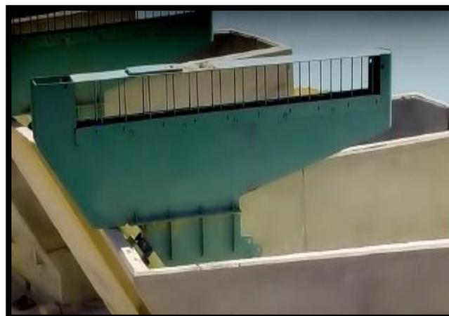
**Figure III.16:** Puits d'alimentation solidaire de la hausse (en acier) (hambarek, 2016).
