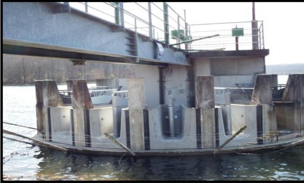
**Figure III.13:** Hausses en corolle sur un déversoir en tulipe Barrage de la Gouyre (6)
