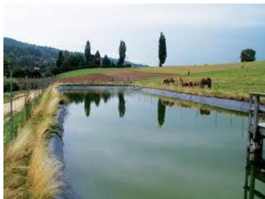
Figure 3 : images d'un bassin en géomembrane
