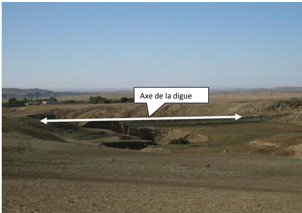
Figure I.3 : vue de la digue a partir de la cuvette (source DRE MEDEA 2016)
