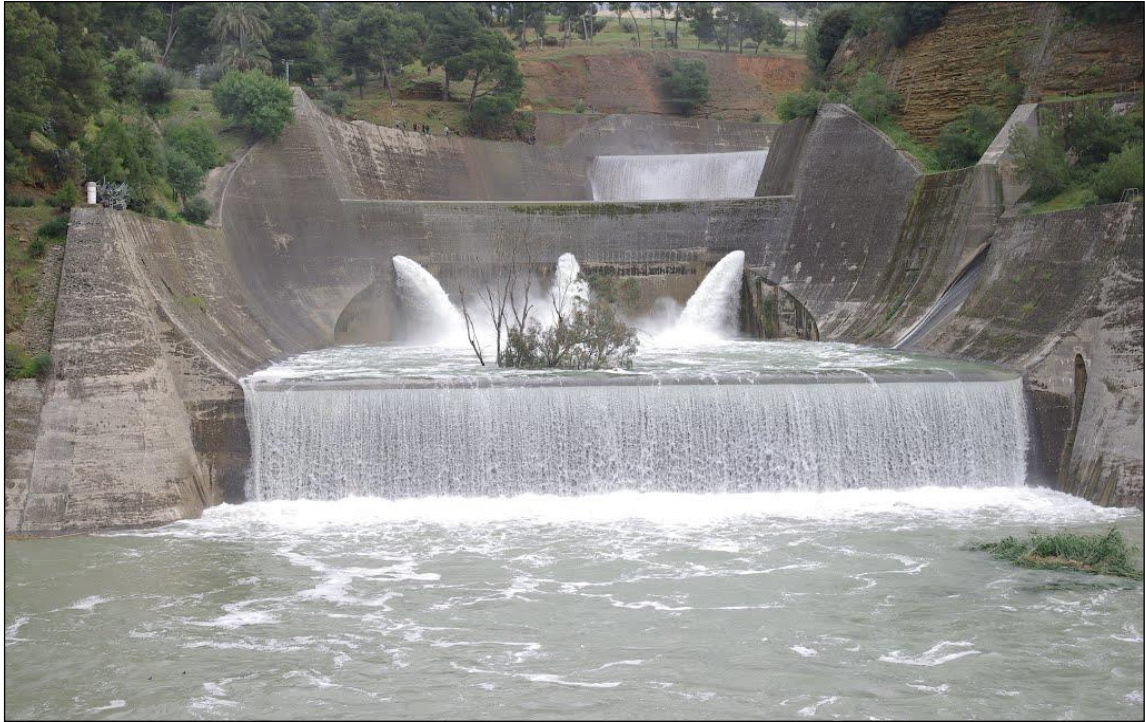
Figure I.7 Déversement de l'évacuateur de crue (anonyme, 2012).
