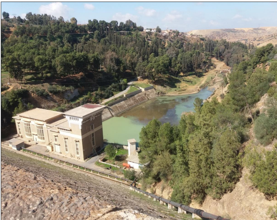
Figure I.11 Vu extérieure de l'usine électrique (Azzi, 2016).
