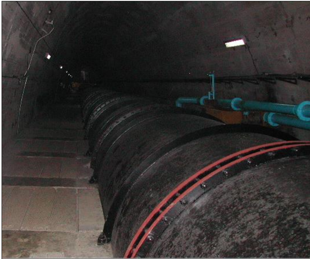
Figure I.10 La conduite forcée du barrage du Ghrib (ANBT,2003).
