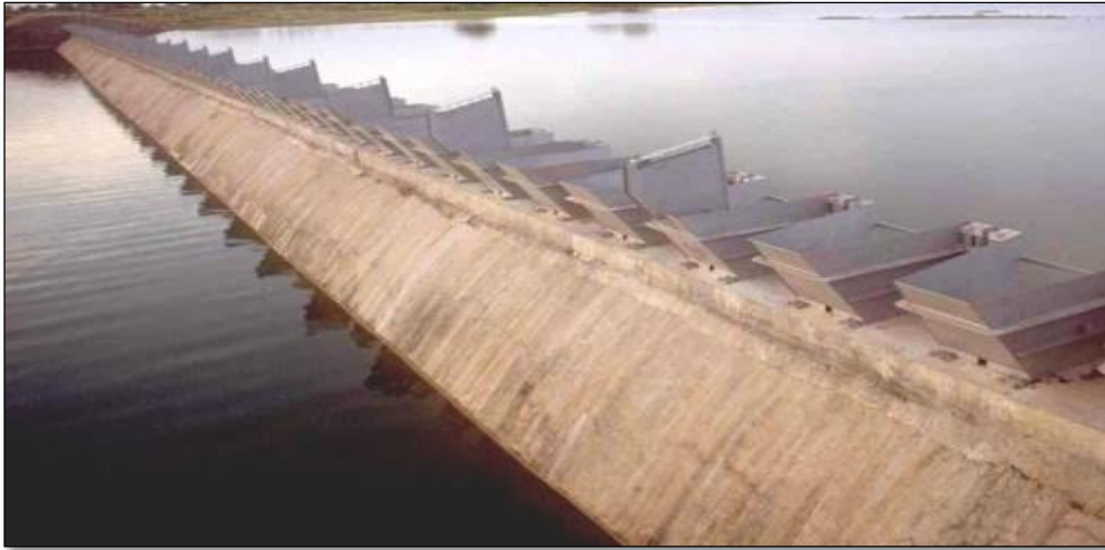
Figure III.10 Puits commun entre plusieurs hausses, exemple du barrage Chopadvav, Inde (Hydroplus, 2016).
