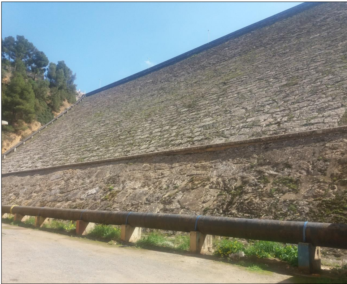
Figure I.12 Parement aval du barrage du Ghrib (Azzi, 2016).
