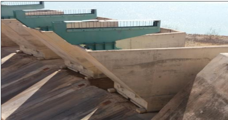
Figure III.8 Puits d'alimentation en acier du barrage Ghrib, Algérie (Azzi, 2016).
