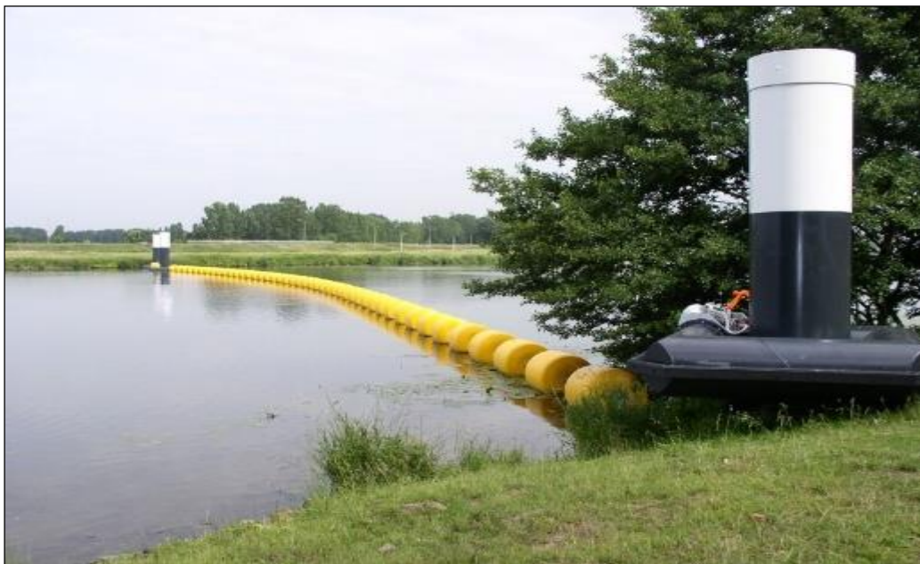
Figure III.18 : Capture des corps flottants avec une drome (Booms, 2015).
