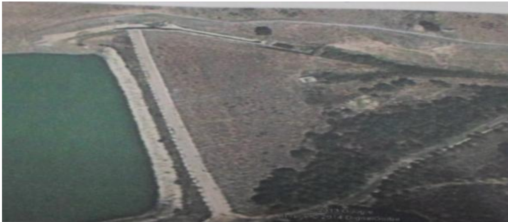
Figure N° III-2 : la digue de la retenue de l'oued Rahil.
