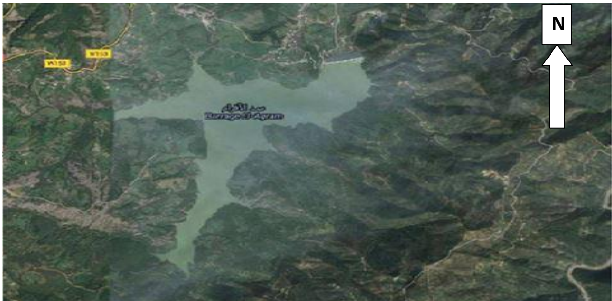
Figure II.1 : Image satellitaire (non traitée) du barrage d'El Agrem (échelle : 1/50000)
