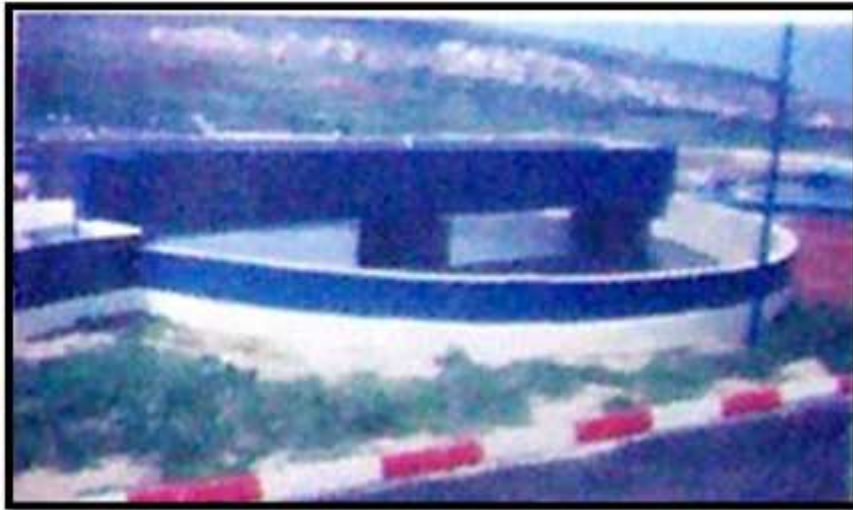
Photo III .8: L'épaississeur de la STEP d'AIN EL HOUTZ.
