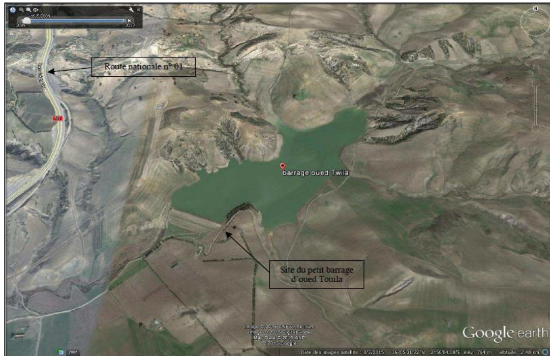
Figure III.1 : Vue aérienne représente situation du petit barrage d'oued Touila (google earth)
