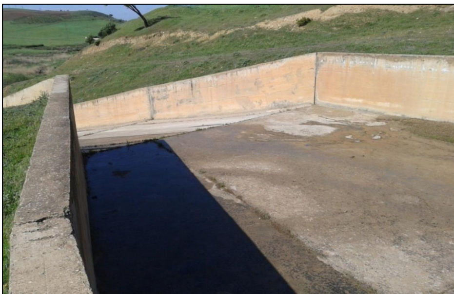
Figure II.3 : Vue de l'évacuateur de crue (HYDRO PROJET, SARL .Décembre2015)
