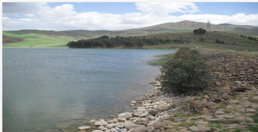
Figure II.4 : Vue de la digue du barrage (HYDRO PROJET, SARL .Décembre 2015)
