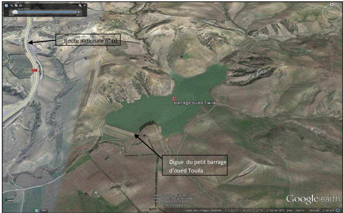
Figure II.2 : Vue aérienne représente le petit barrage d'oued Touila (google earth)
