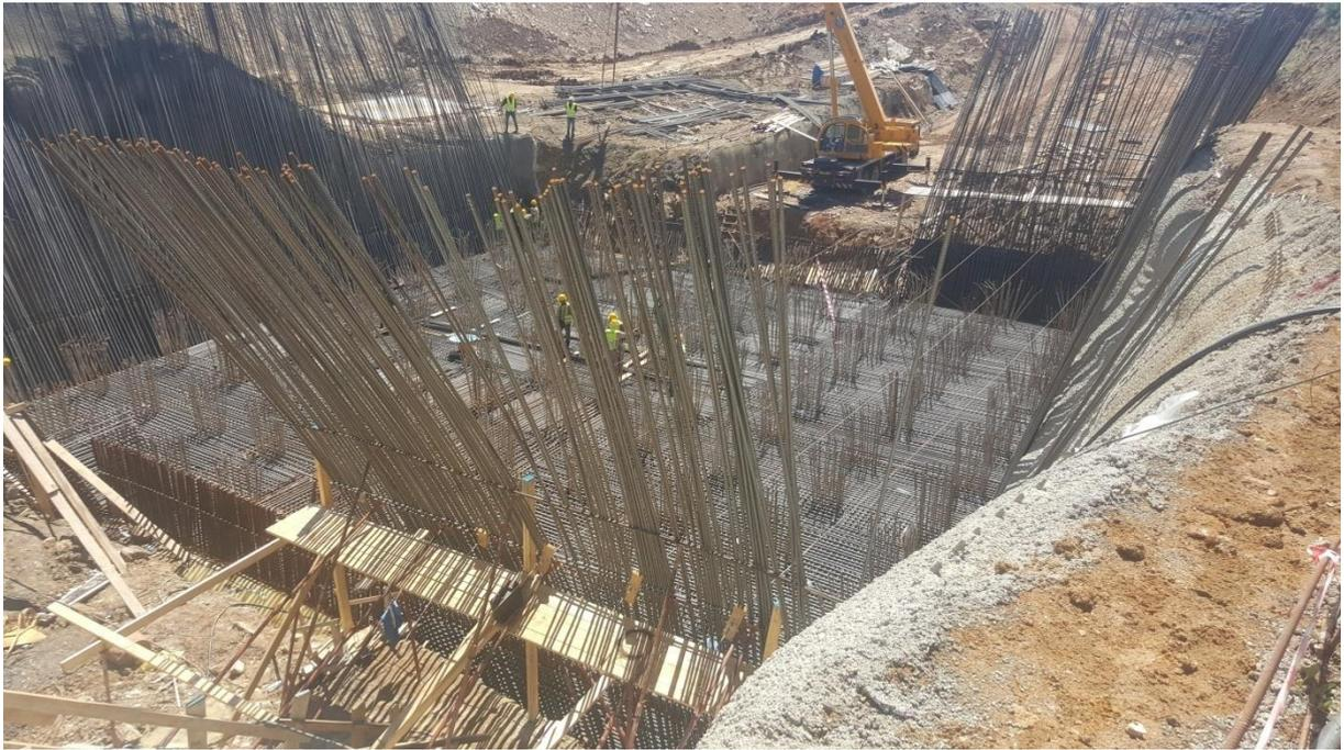
**Figure 01 :** Ferrailage de la fondation de la tour de prise d'eau
