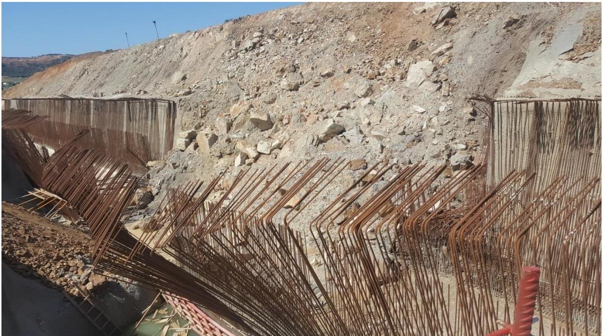
**Figure 10 :** Glissement de terrain sur la paroi droite de la vidange de fond
