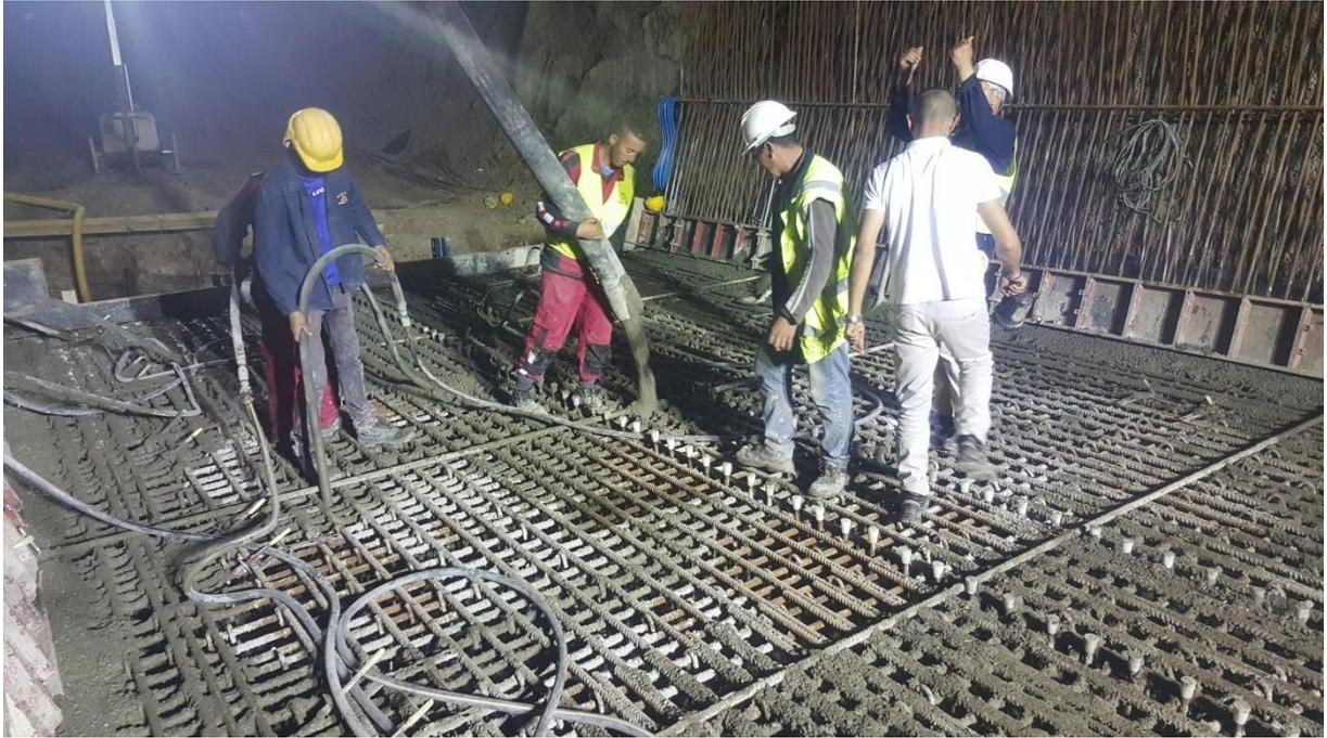
**Figure 11 :** Bétonnage de la fondation de l'ouvrage de la vidange de fond
