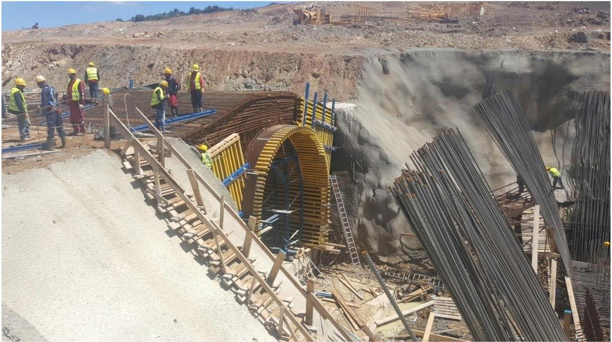
**Figure 05 :** Ouvrage d'entrée de la galerie de vidange de fond
