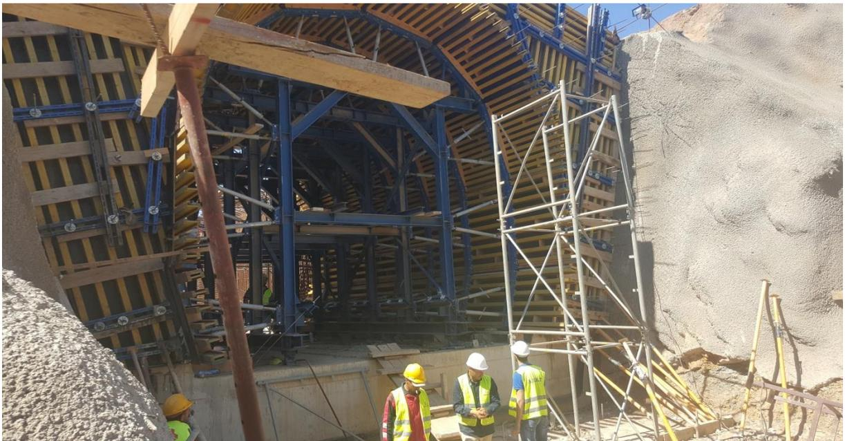
**Figure 06 :** Ouvrage d'entrée de la galerie de vidange de fond (fer a cheval)
