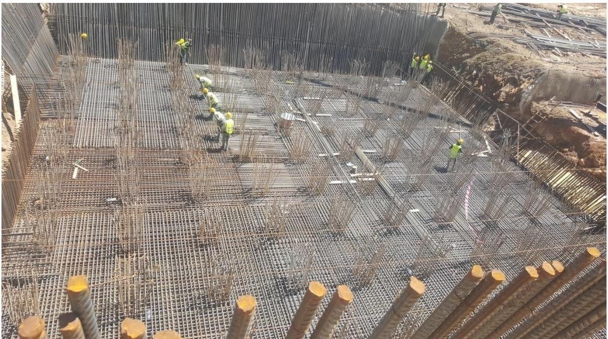
**Figure 02 :** Ferrailage de la fondation de la tour de prise d'eau
