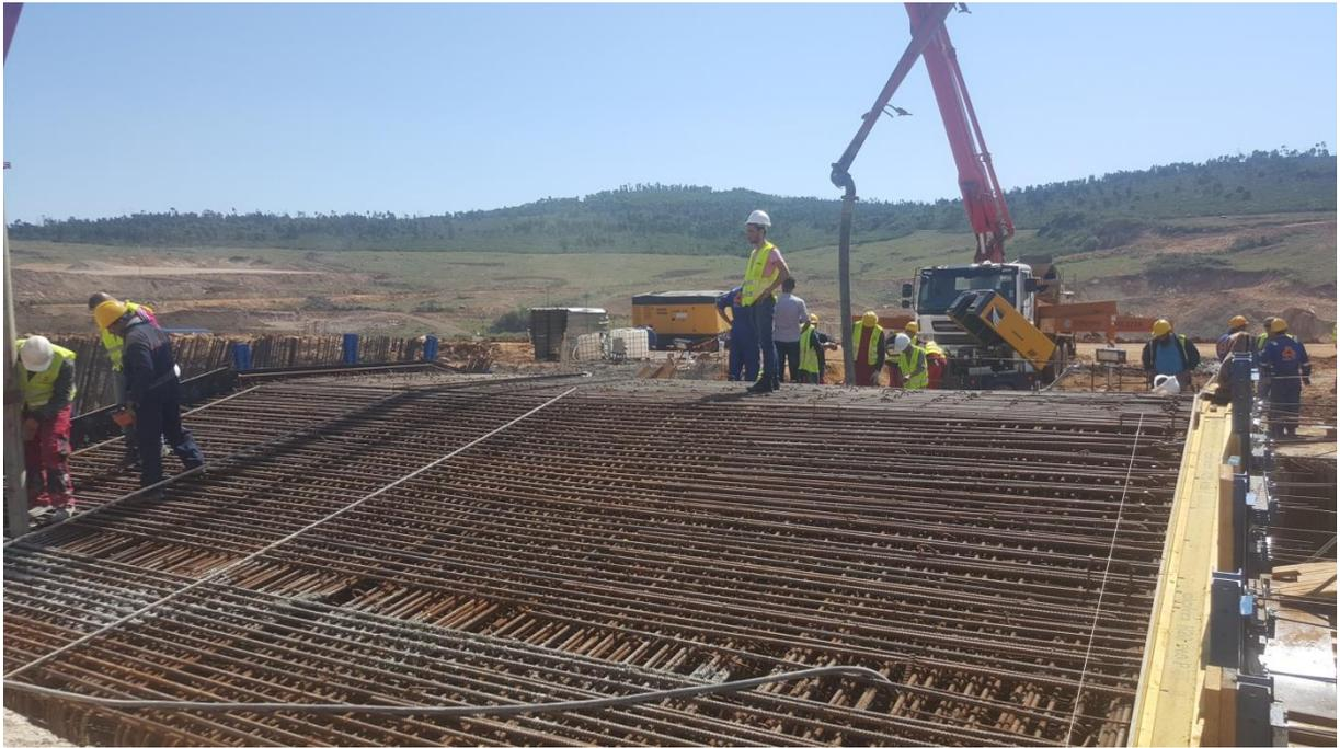
**Figure 09 :** Préparation du bétonnage de la voute de la galerie de vidange de fond
