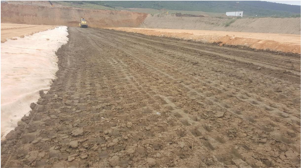
**Figure 03 :** Compactage du noyau en argile du batardeau
