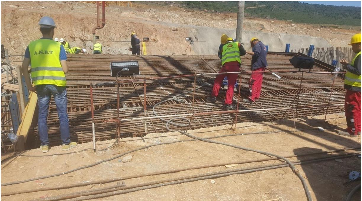
**Figure 08 : Bétonnage de la voute de la galerie de vidange de fond**
