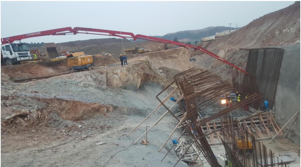
**Figure 12 :** Bétonnage de la fondation de l'ouvrage de la vidange de fond
