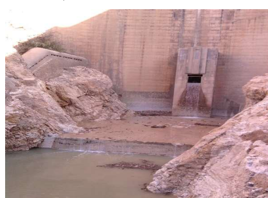
Figure (1.20) : Extraction des sédiments dans le barrage Foug el Gherza
