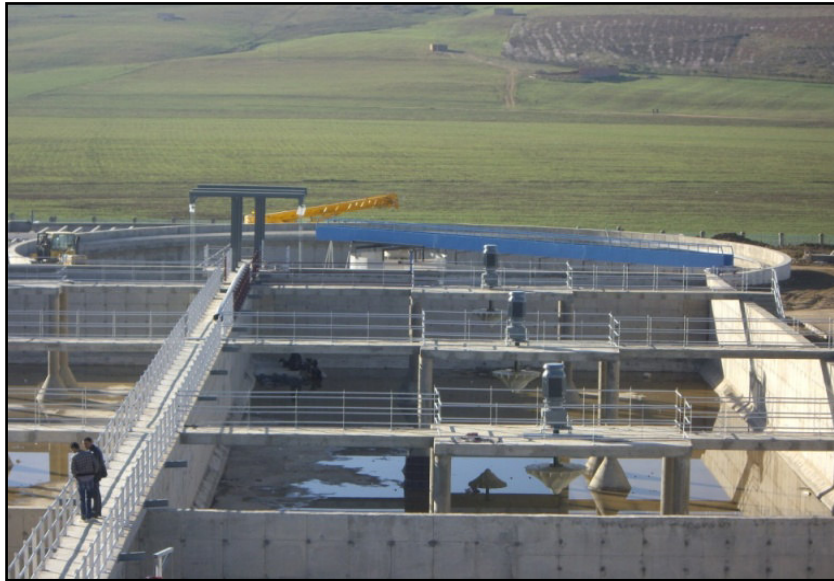
Figure III-09 : photo réelle du décanteur secondaire.
