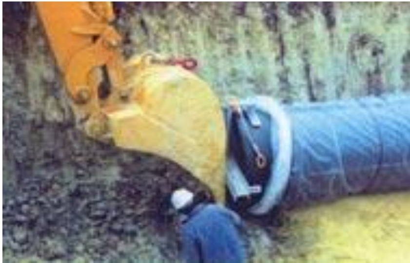
Fig .IV.5: Pose de conduites dans un terrain agressif.
