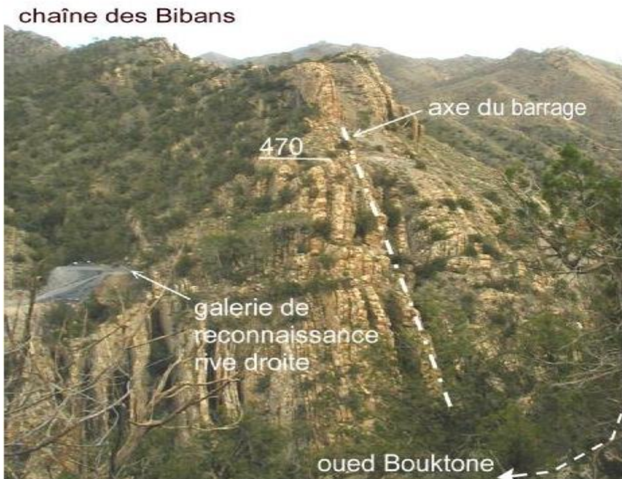
Figure III.1 : Photo illustrant l'axe du barrage « Portes de Fer », Source [ANBT]
