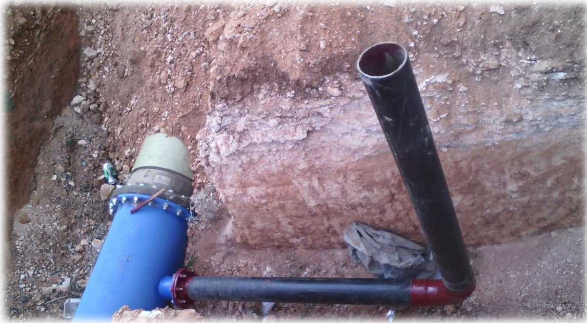
Picage d'une conduite secondaire à une borne d'irrigation
