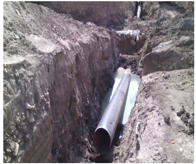
Figure VIII-1 : Pose canalisation (Périmètre Haut Isser- Avril 2016)
