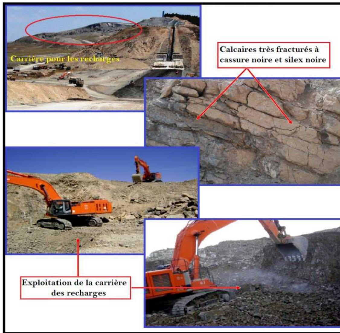
Figure II.5 La zone d'emprunt des calcaires pour les recharges
