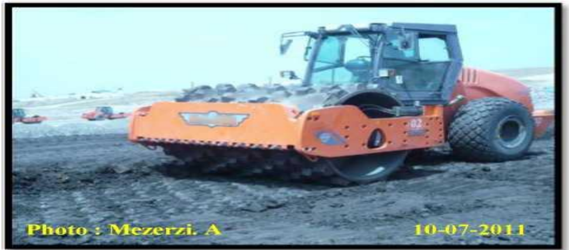
Compactage des argiles
