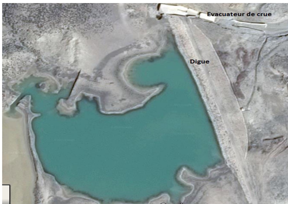
Figure III.2 : Photo satellitaire montre les ouvrages de base de la retenue collinaire EL AGBA (source : Google earth, 20016)
