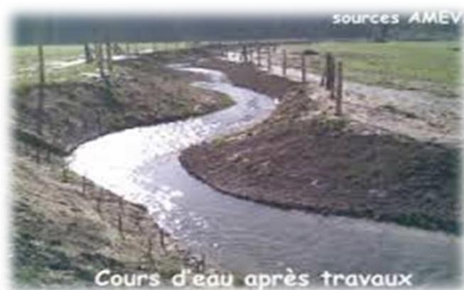
**Figure V.4 :** reprofilage d'un cours d'eau.
