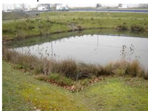
**Figure V.19** : Bassin de rétention par infiltration. ([hmf.ensee.ht.fr](http://hmf.ensee.ht.fr))
