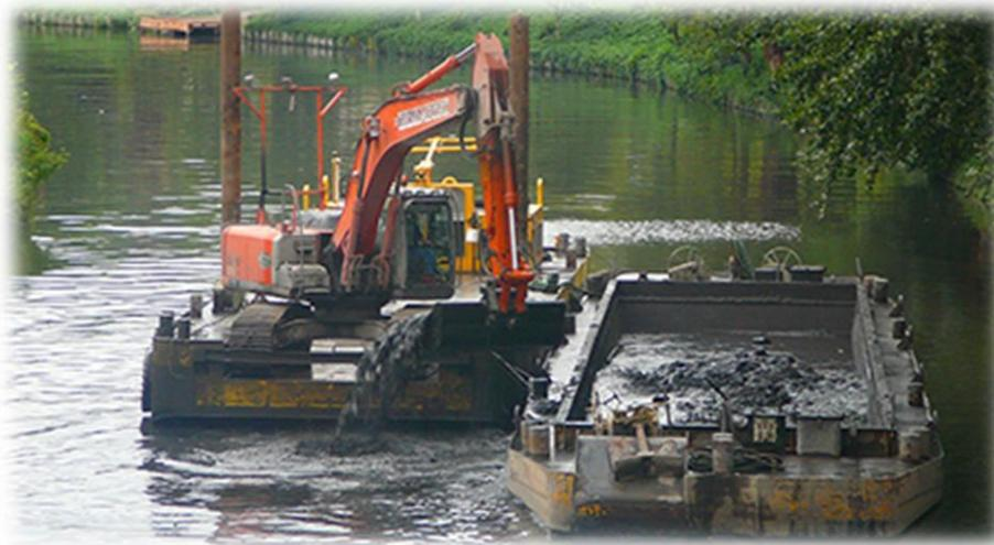
**Figure V.2 :** Dragage d'un cours d'eau
