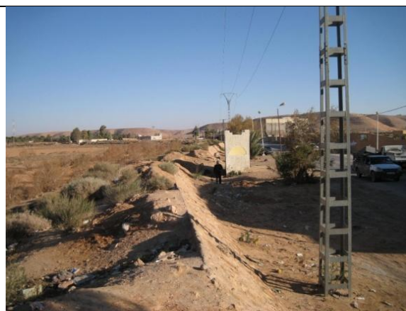
figure N° I.3: Vue talus aval
