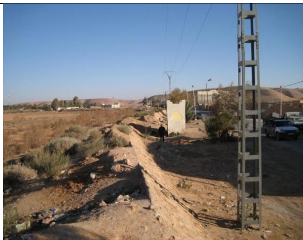
figure N° I.4 : Digue talus aval avec la ligne électrique moyenne tension
