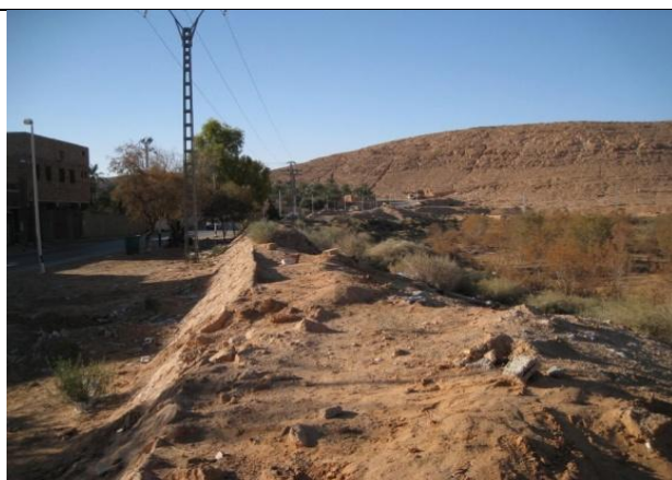
figure N° I.2 : Vue talus aval en pierre maçonnée
