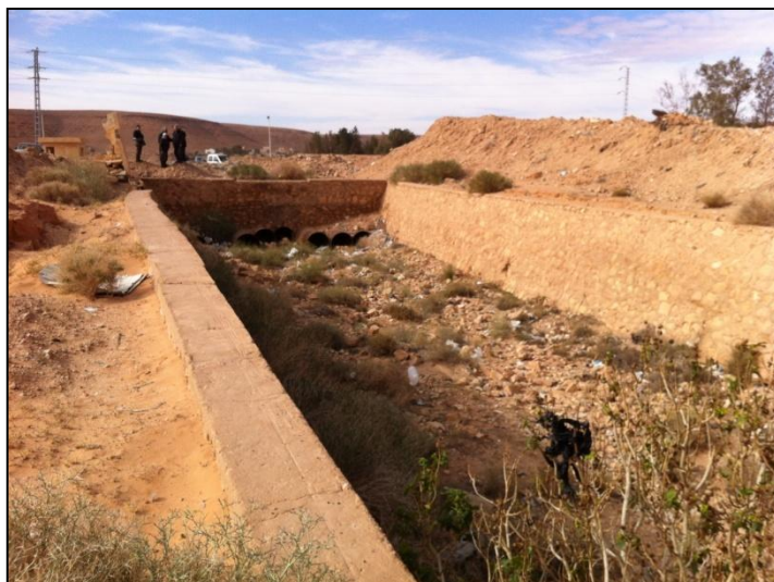
Figure N° I.1 Vue évacuateur à partir de l'aval (DRE de Ghardaïa)
