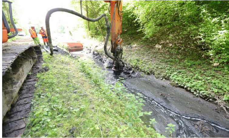
FIG. 5.1 : curage d'un cours d'eau.
